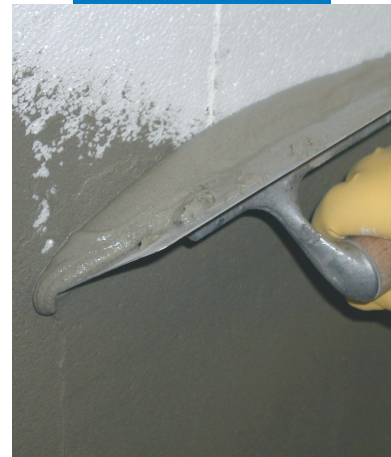
Εξομάλυνση θερμομονωτικών πλακών: Άπλωμα του Mapetherm AR1
