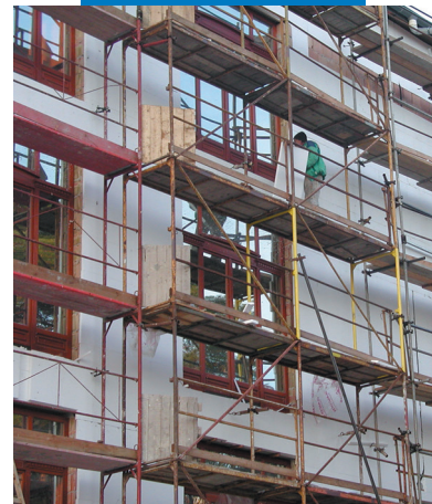
Συγκόλληση των μονωτικών πλακών στην εξωτερική όψη με Mapetherm AR1
