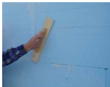
22. Λείανση με τριβίδι γυαλόχαρτου
