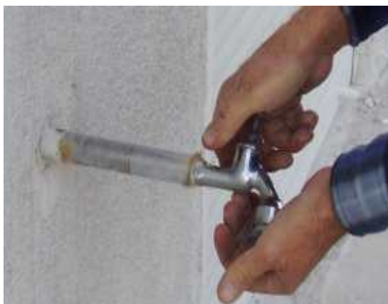
1. Προέκταση υδραυλικής εγκατάστασης
