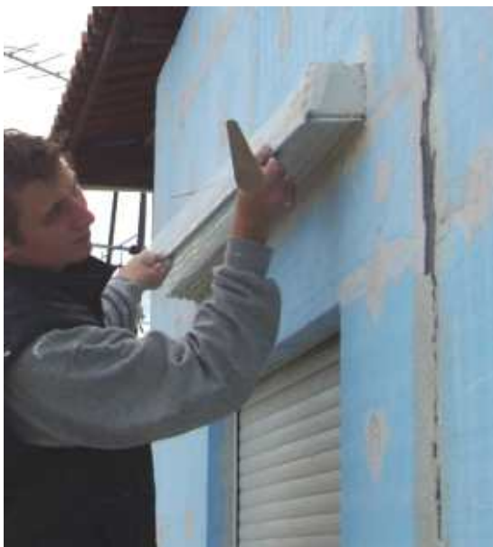
39. Τοποθέτηση σταθερού γωνιόκρανου με νεροσταλάκτη
