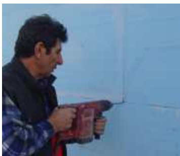
24. Διάτρηση με δράπανο
