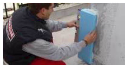
9. Κόλληση ειδικών τεμαχίων BSK
